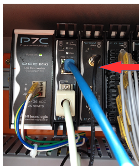
Figura 14 - Controlador P7C utilizado no armário de comando ACOS216
